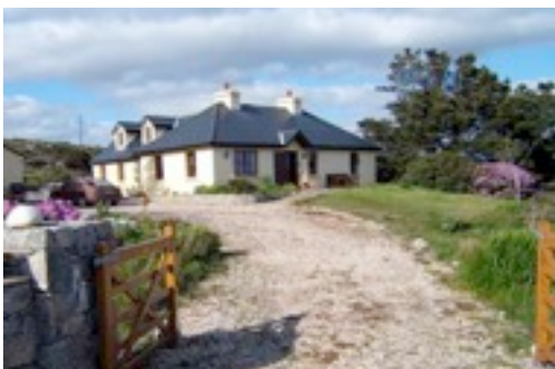
Die Einfahrt zum Haus
